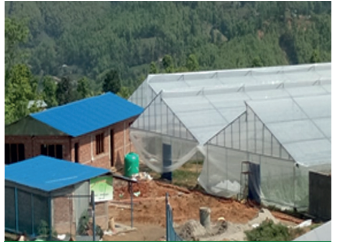
२ रोपनी क्षेत्रफलमा निर्माण गरिएको GI Pipe सहितको प्लाष्टिक टनेल
