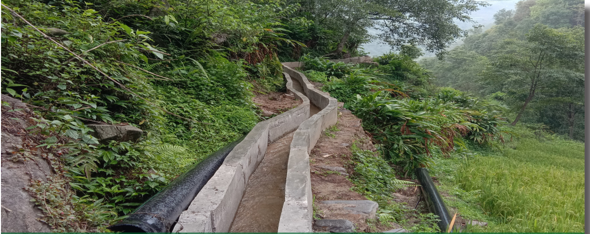
साना सिञ्चाई निर्माण कार्यक्रम अन्तर्गत ककनी गा.पा.-०६ मा निर्मित सिञ्चाई कुलो
